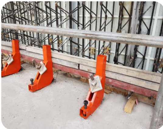
하부 앵커볼트 체결 상태
